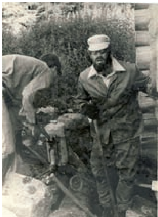
Подъём на метр колокольни с помощью гидравлического домкрата близ Кижей
